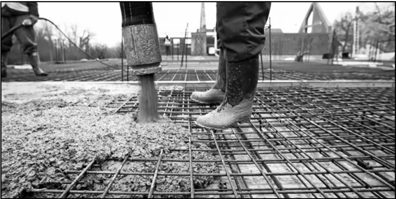
Concrete Pour With Rebar Structure
