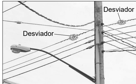
Línea eléctrica con desviadores
